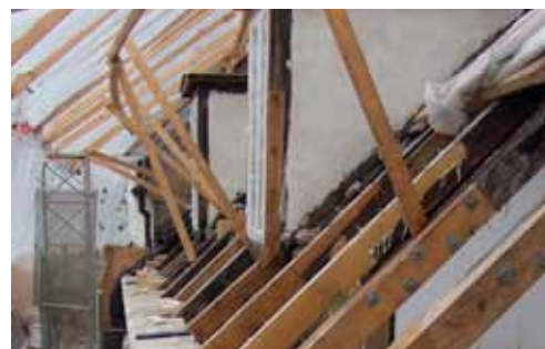
7. Ved reparation efter Ægte Hussvamp fjernes angrebet træ, hvorefter murværk og erstatnings træ behandles med Boracol Special.
