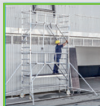
Diagonalstivere forbindes med stilladsrammen.
