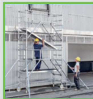
Næste platform monteres fra et sikkert ståsted.
