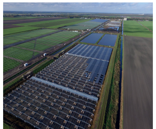
Solcellepark i Holland, funderet på Centrum Pæles MFP. I fremtiden vil også udendørs parkeringsarealer med overdæk bestående af solcellepaneler være funderet på MFP.
