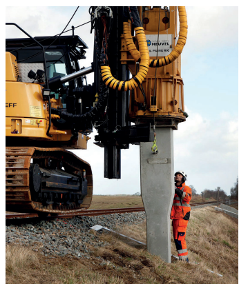
Installation af MFP som fundament til elektrificeringsmast på jernbanenettet.
