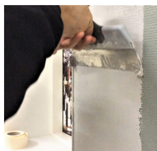
Påfør 1 mm spartelmasse
