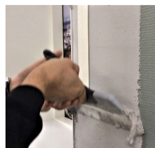
Skjul Unique listen med spartelmasse, der trækkes helt til spartelkant.
