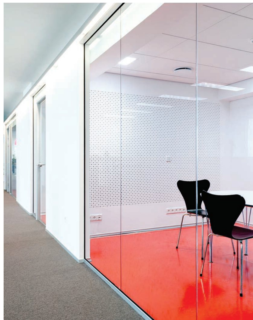
DEKO FG MED SKJULTE PROFILER I VÆG
