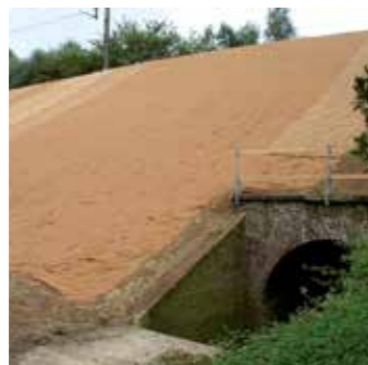
Skråningssikring med GREENFIX Eromat på en stejl jernbaneskrænt.
