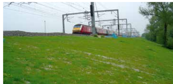
Vegetation Etablering og beskyttelse mod gnavere med GREENFIX f 3 Rockmat .
