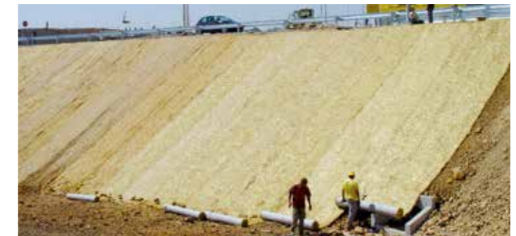
Motorvejsskrænt beskyttet med Covamat plus i Lissabon, Portugal.
