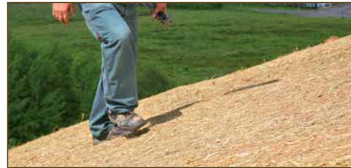
16.2 Den nemme og hurtige måde at installere Greenfix måtter på.
