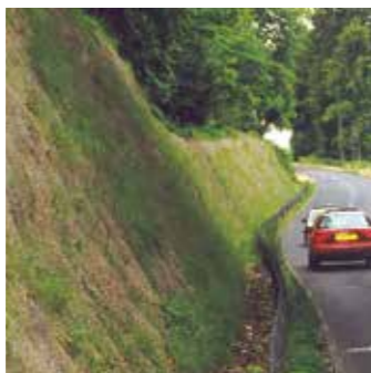
Skrån timer dækket med GREENFIX Rockmat , seks uger efter installationen.
