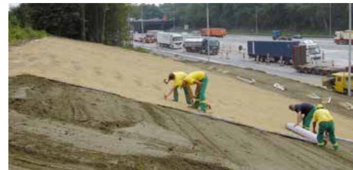
Ca. 60.000 m 2 Covamat fresh er blevet installeret ved ringvejen ved Antwerpen, Belgien.
