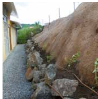
Vellykket installation af GREENFIX Rockmat Type 6D i Ny Kaledonien
