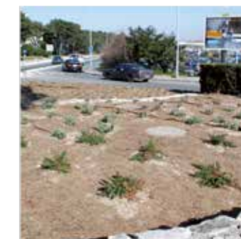
Plantebeskyttelse med GREENFIX f 3 Mulchmat i en rundkørsel i det sydlige Frankrig.
