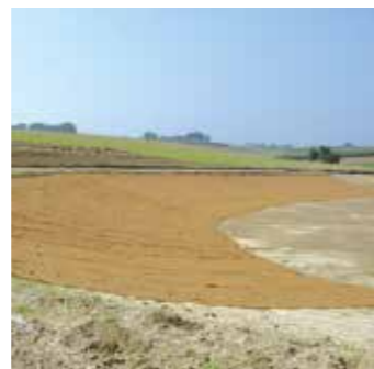
Projekt med GREENFIX Eromat ved regnvandsbassin.
