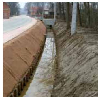
Skråningssikring med GREENFIX Eromat langs grøfte.
