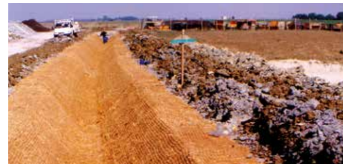
Beskyttelse af vejgrøft med Covamat plus .
