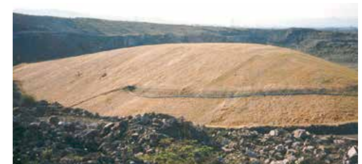
Overdækket deponi, færdiginstalleret erosionsbeskyttelse med Covamat plus .
