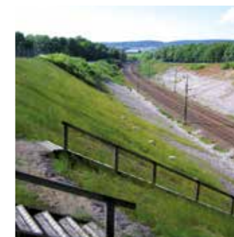
GREENFIX f 3 Covamat (seks uger efter installering).
