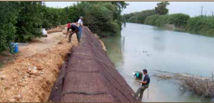
14.1 Kystlinje beskyttelse med Greenfix 75-C
