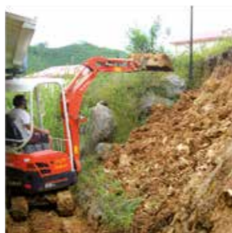
Genetablering af skrån timer udføres efter voldsom regn.
