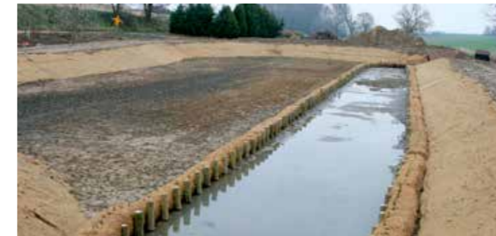
Bio-Logs (kokosruller) leveres med plantehuller for hurtig og effektiv plantning af vandplanter.
