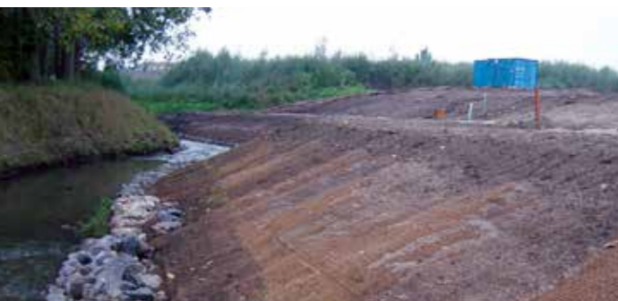
GREENFIX Embankment Mat typ 400S i brug.
