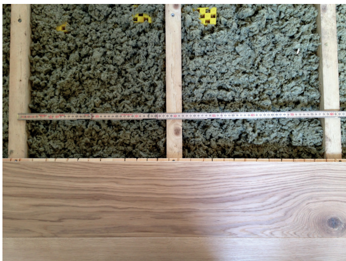
Figur 4 Klima skal være indreguleret for lægning af trægulv.
