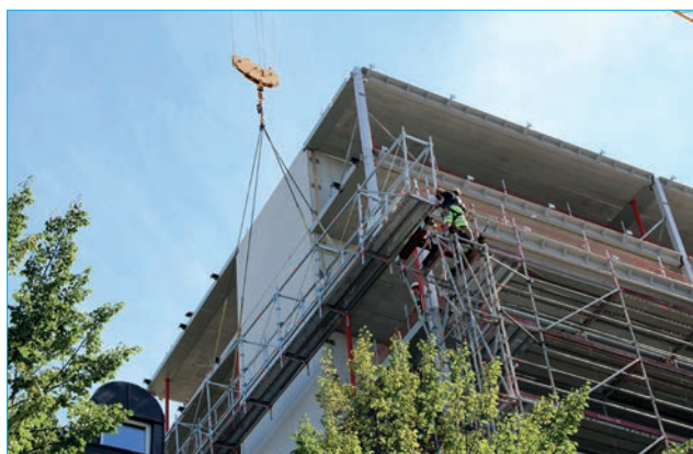
Allround FW gangbro løftes på plads med kran.
