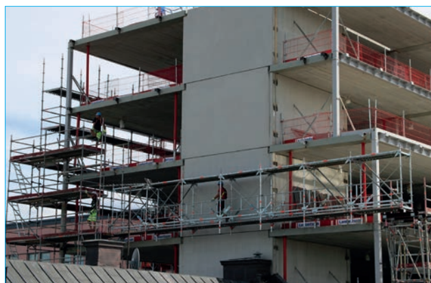
Allround FW gangbro integreret i det eksisterende stillads.
