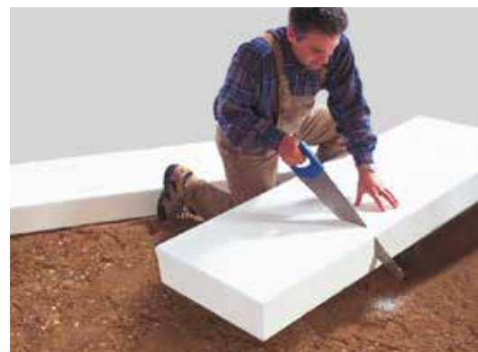
Sundolitt udlægges i forbandt. Start i sokkelhjørne.
