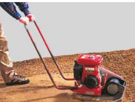
Terrænet afrommes til bæredygtigt niveau. Eventuelt afretningsgrus udlægges og vibreres.
